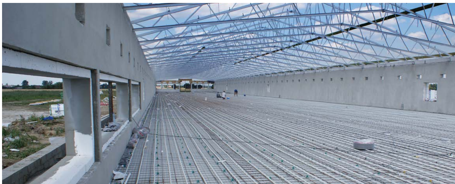
Instalacja KAN-therm ogrzewania hali kurnika (2500 m 2 ) hodowli ściółkowej
